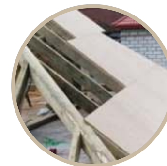
Podbite pod strešnou krytinou z dosiek MFP
